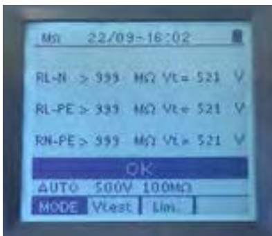
Isolationsmessung gegen alle Leiter L-N-PE
