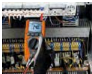
RCD Auslösezeit t_a und Auslösestrom I_a
