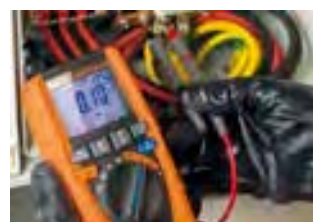
Durchgangsprüfung von Schutzleitern.
