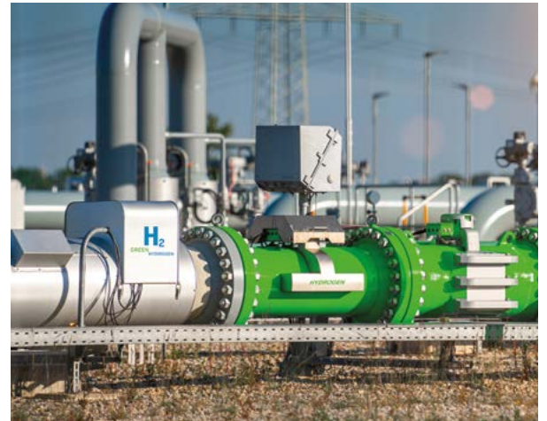
Grüner Wasserstoff braucht nachhaltig erzeugten Strom. Bender sorgt dafür, dass beispielsweise PV-Felder elektrisch sicher sind.
