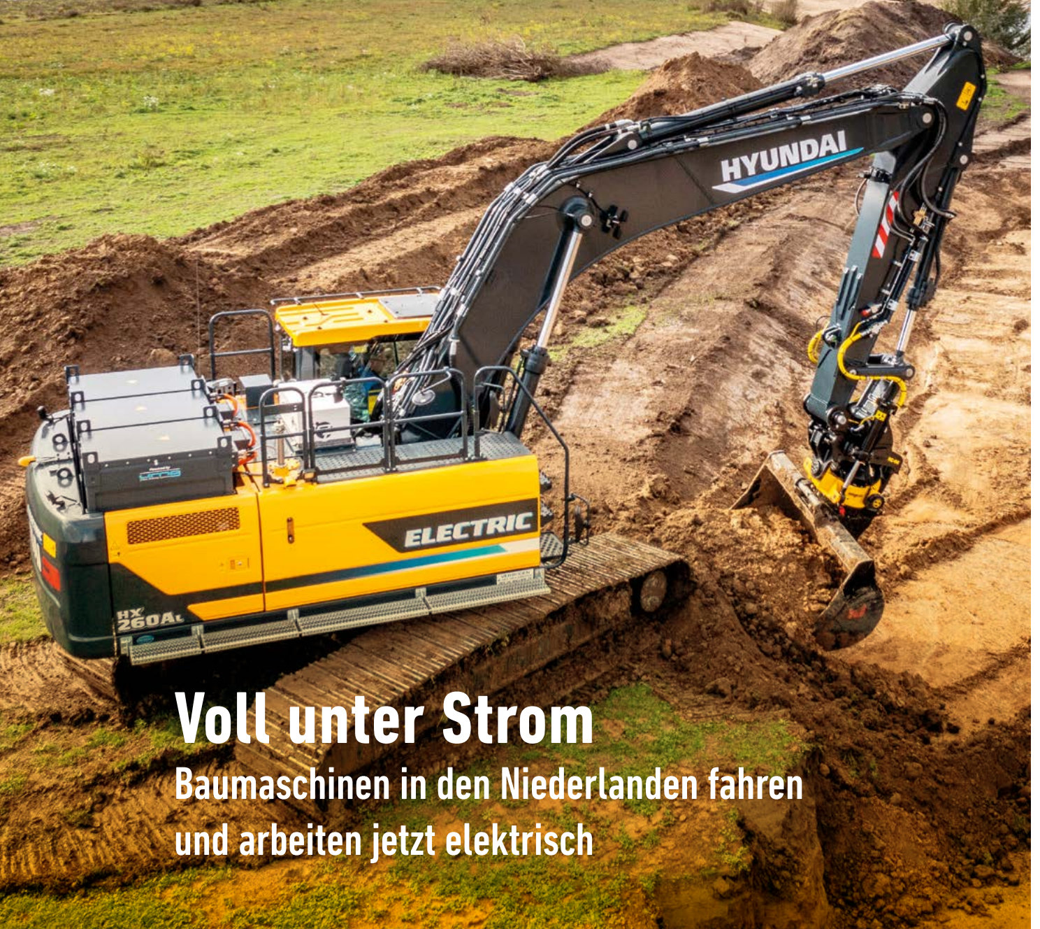
E-Bagger bei der Arbeit: Die Stromversorgung erfolgt über drei austauschbare Batteriepakete.
