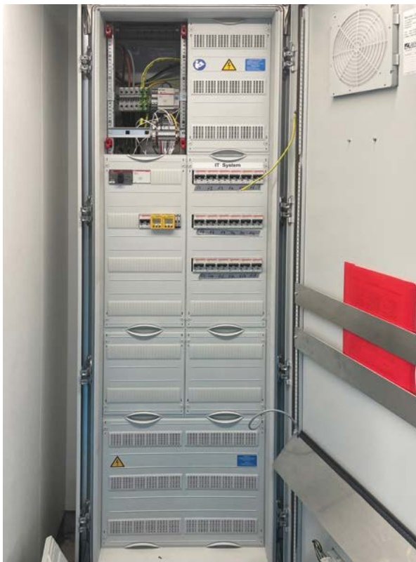
Die Einspeiseverteilung der OP-Räume wurde neu eingebaut.
