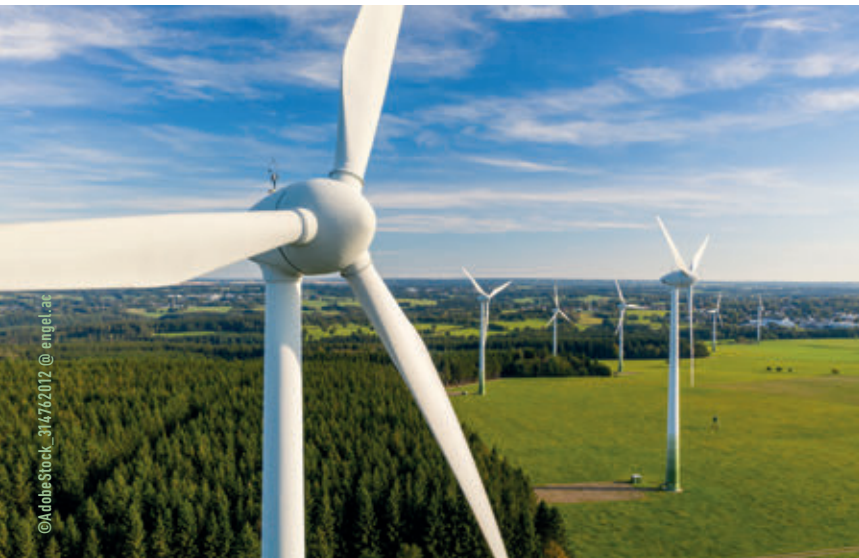
Nachhaltig erzeugter Strom braucht elektrische Sicherheit – Bender hilft.
