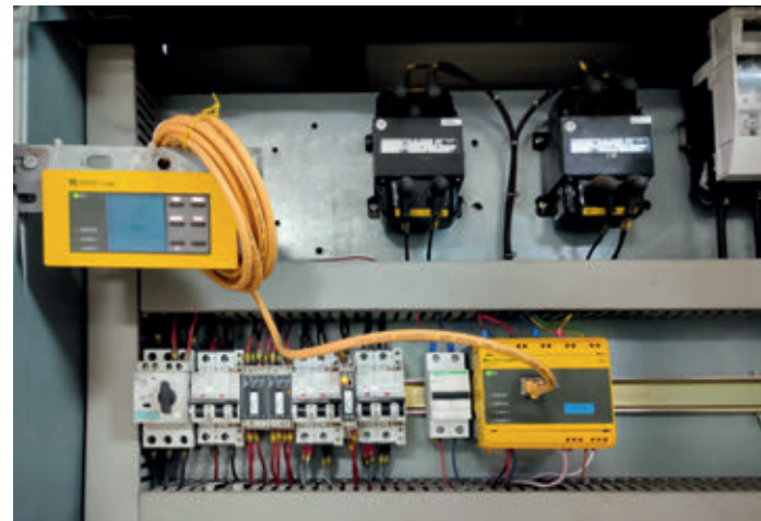
Das ISOMETER® iso685-P überwacht den Isolationswiderstand des ungroundeten Netzes, der IR-Wert wird auf dem Display angezeigt.
