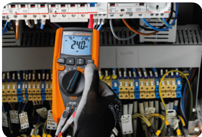
Verifica tempo e corrente d'intervento RCD.
