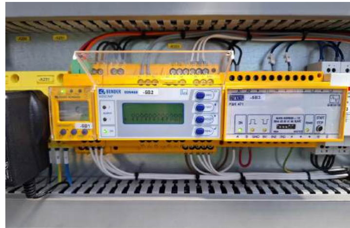
Schmales Gerät links: LPR-Messung (Low Parallel Resistance) Zwei Geräte rechts: HPR-Messung (High Parallel Resistance)
