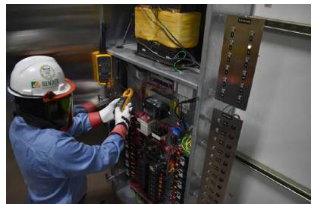
Bei der normgerechten Re-Zertifizierung der Anlagen werden Störungen simuliert und die ausgelösten Alarmer überprüft.
