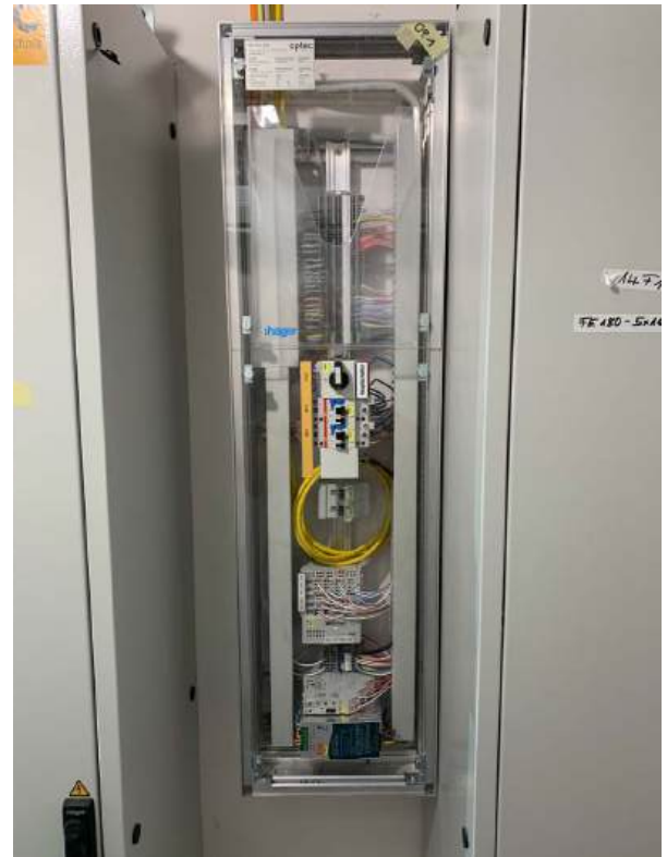
Die abgesetzte Steuereinheit bildet die Grundlage der elektrischen Sicherheit
